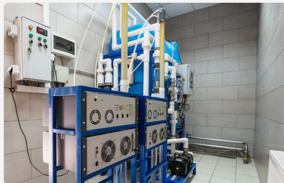
Figura 8. Imatge d'una planta de tractament d'osmosi inversa.
